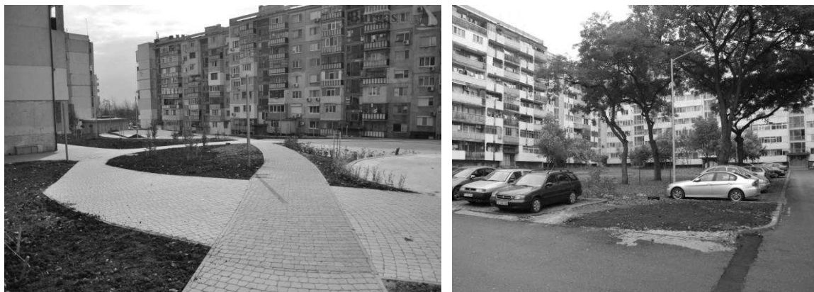
фиг. 1 Междублокови пространства в комплекс „Меден рудник“, гр. Бургас
