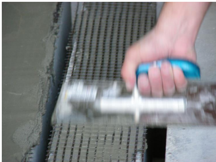
Фиг. 3. Полагане на финия бетон върху въглеродната армировъчна мрежа
