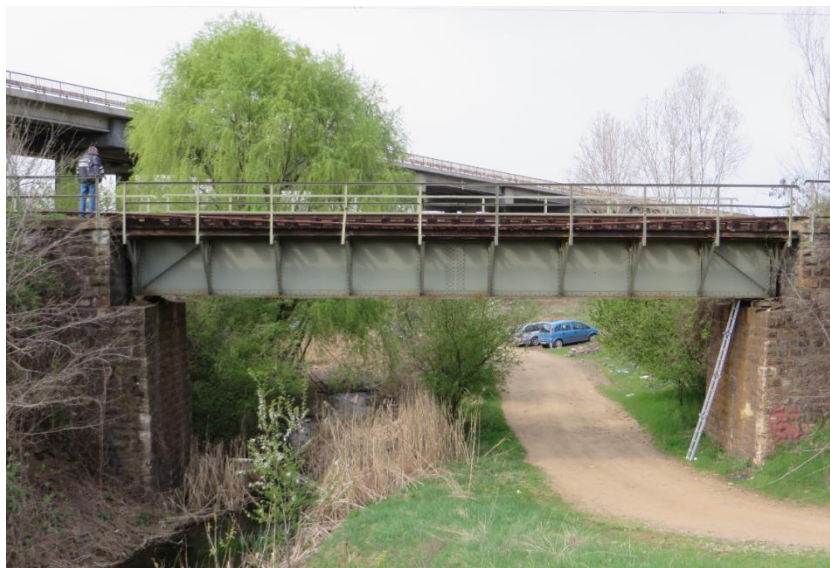
Фиг. 1. Стар стоманен нитован железопътен мост с пълностенни главни греди и отвор L = 15 m
