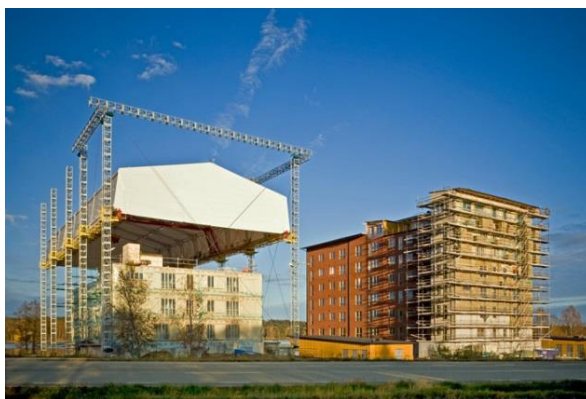
Фиг. 10. Изпълнение на сгради по безскелетна конструктивна система от плочи от многослойна дървесина
