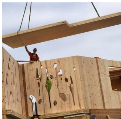
Фиг. 10. Изпълнение на сгради по безскелетна конструктивна система от плочи от многослойна дървесина
