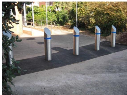
Фиг. 2. Anti-RAM бариери за предотвратяване нарушаването на периметъра на съоръжението от превозни средства
