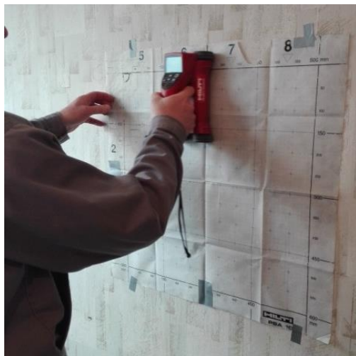
Фиг. 7. Площно сканиране на носещ стенен панел
