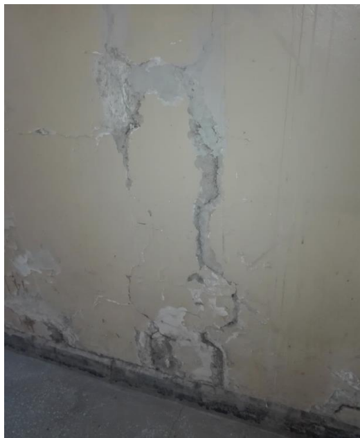
Фиг. 1. Пукнатини по контура на вертикално дюбелно съединение
