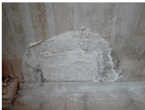
Фиг. 5. Общ вид на разкрито дюбелно съединение
