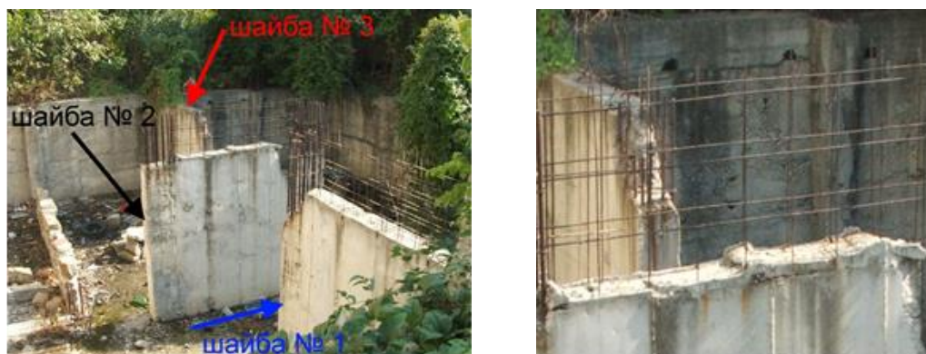
Фиг. 1. Общ поглед на основите на строежа и местата за вземане на пробни тела
