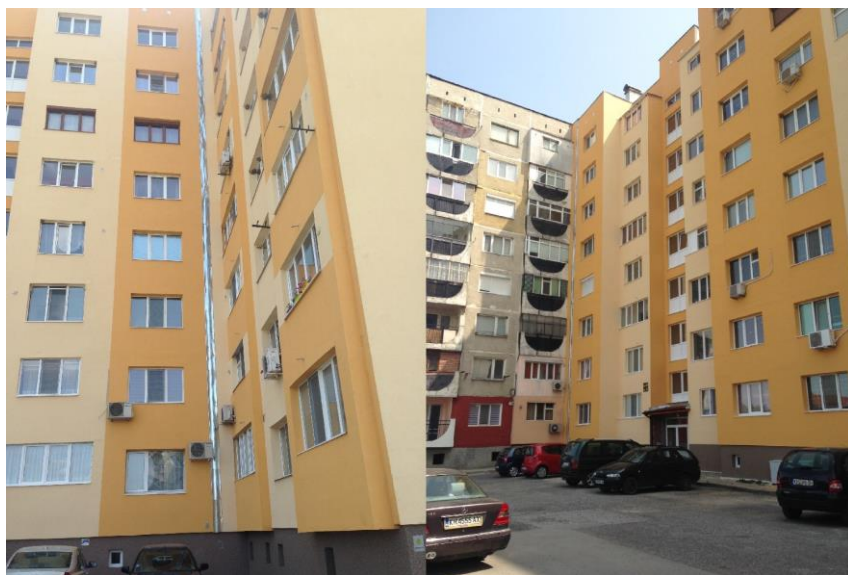
Фиг. 3. Фасадата на сградата в завършен вид
