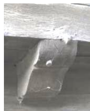
Фиг. 12. (1) Дървена клечка, свързваща греда от подовата конструкция с долна греда, (2) Свързване на подовите греди с долната греда чрез зарязване, (3) Детайл при скосен ъгъл на фасада, (4) Сглобка в ъгъла на фасадата при еркерна излизане
