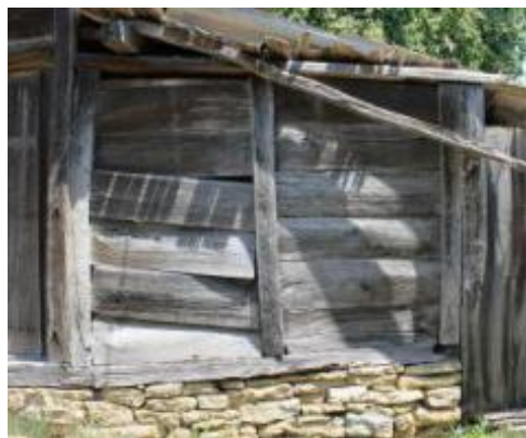
Фиг. 27. Разместване на талпи
