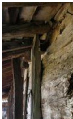
Фиг. 29. Нарушени връзки между притисквачи и греди
