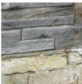
Фиг. 10. Снаждане на долни греди по дължина с (1) косо зарязване, (2) право зарязване, (3) косо челно опиране
