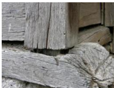
Фиг. 7. Сглобка „гълб и зъб“ при връзка спонец-долна греда (ляво) и връзка спонец-горна греда с дървена клечка (дясно)
