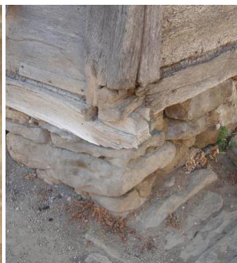
Фиг. 22. Гниене във възел долни греди-спонец, разположен близо до терена
