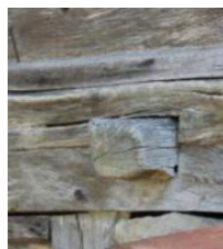
Фиг. 12. (1) Дървена клечка, свързваща греда от подовата конструкция с долна греда, (2) Свързване на подовите греди с долната греда чрез зарязване, (3) Детайл при скосен ъгъл на фасада, (4) Сглобка в ъгъла на фасадата при еркерна излизане
