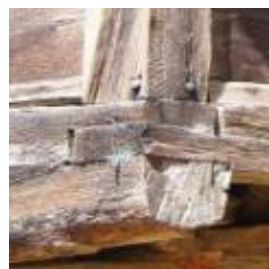
Фиг. 11. Сглобки в ъглите на фасадите при долни греди: (1) Косо зарязване, (2) просто странично зарязване, (3) право зарязване в ъгъл
