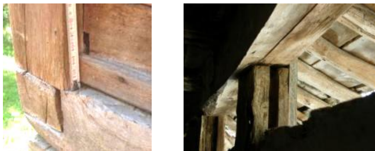
Фиг. 3. Оформяне на жлебовете при долен ръб (ляво) и горен ръб (дясно)
