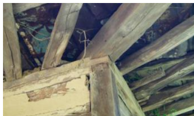
Фиг. 14. Връзка на горните греди с покривния гредоред
