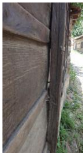
Фиг. 17. Връзка между притисквач и талпа с кован пирон
