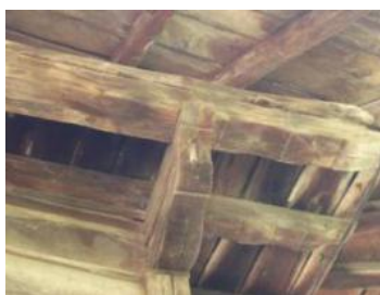
Фиг. 15. Конзолно излизане на горна греда с допълнителен подложен елемент
