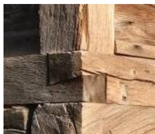
Фиг. 11. Сглобки в ъглите на фасадите при долни греди: (1) Косо зарязване, (2) просто странично зарязване, (3) право зарязване в ъгъл
