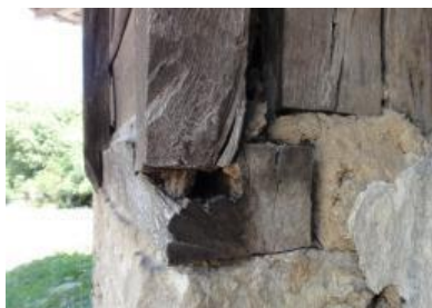
Фиг. 23. Гниене във възлите и разместване на стената извън равнината ѝ. Възелът на дясната снимка е вътрешно изгнил
