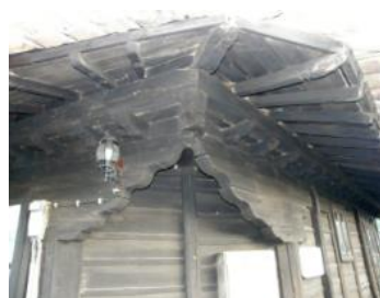
Фиг. 16. Детайл за постигане на правоъгълен план на покрива при етаж с неправилна конфигурация
