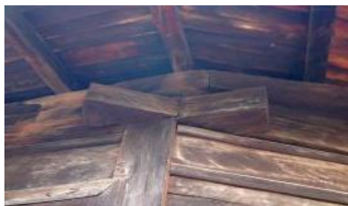
Фиг. 13. Пресичане на горни греди с просто странично зарязване
