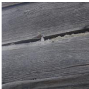
Фиг. 9. Дървени клечки, свързващи талпите по височина на стената. На дясната снимка от Козичковата къща в Стария Котел се вижда, че има едновременно притисквач и дървени клечки
