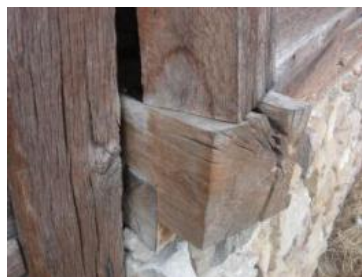
Фиг. 23. Гниене във възлите и разместване на стената извън равнината ѝ. Възелът на дясната снимка е вътрешно изгнил
