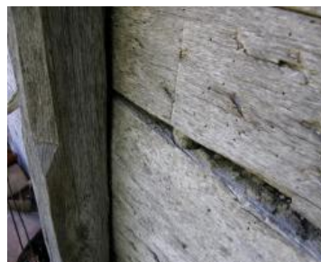
Фиг. 9. Дървени клечки, свързващи талпите по височина на стената. На дясната снимка от Козичковата къща в Стария Котел се вижда, че има едновременно притисквач и дървени клечки
