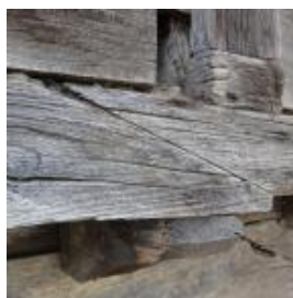
Фиг. 10. Снаждане на долни греди по дължина с (1) косо зарязване, (2) право зарязване, (3) косо челно опиране
