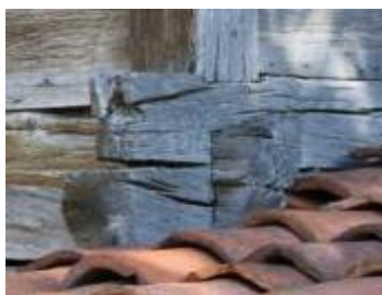
Фиг. 11. Сглобки в ъглите на фасадите при долни греди: (1) Косо зарязване, (2) просто странично зарязване, (3) право зарязване в ъгъл
