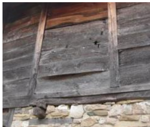
Фиг. 28. Деформация на талпа
