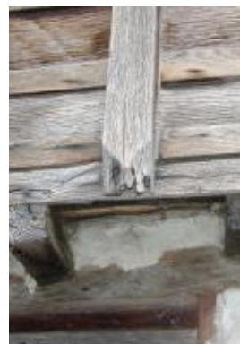
Фиг. 30. Гниещ край на притисквач
