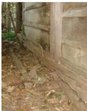
Фиг. 21. Дървена конструкция на нивото на терена
