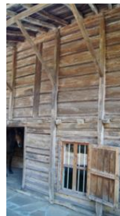
Фиг. 19. Притисквачи, които обхващат две нива
