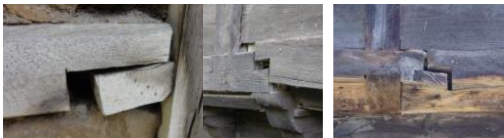
Фиг. 26. Размествания на сглобки
