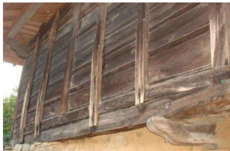
Фиг. 18. Част от притисквачите са свързани с долната греда, а друга част – с подложната греда над каменната зидария
