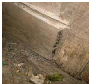
Фиг. 8. Скосяване на талпа преди жлеба на спонеца
