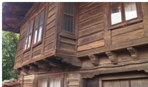
Фиг. 1. Паянтова конструкция с пълнеж от плет и глина в с. Долен (ляво) и талпено-стълбова система в Стария Котел (дясно)
