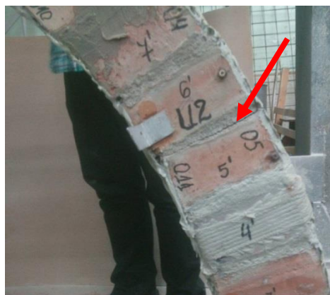
Фиг. 7. Признак на разрушение
