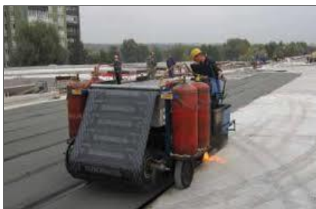
Фиг. 1. Машинно полагане и заваряване на битумно-полимерна хидроизолационна мушамы
