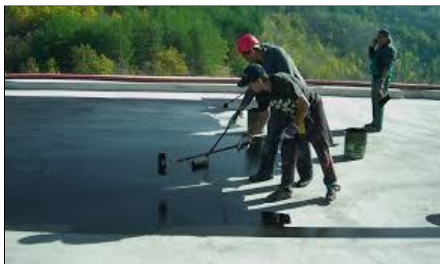
Фиг. 2. Полагане на течни хидроизолационни състави
