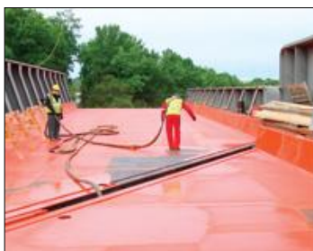
Фиг. 6. Изпълнение на хидроизолация
