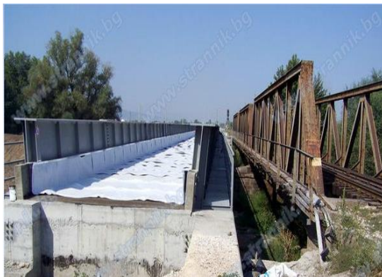
Фиг. 5. Частично изпълнение на хидроизолационна система на комбиниран стомано-стоманобетонен мост (Чая-Катуница)
