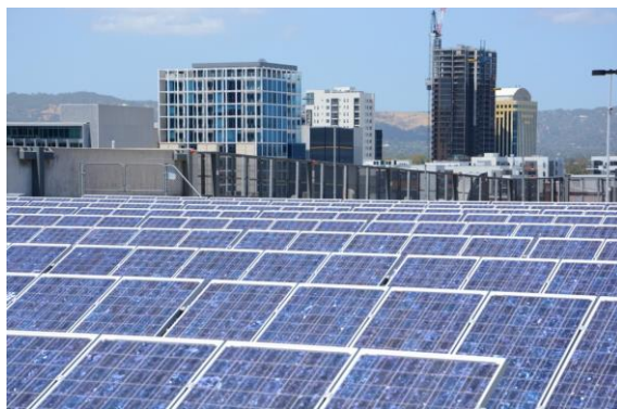
Фиг. 2. Автономна стационарна соларна система на покрив в Аделаида, Австралия [7]
