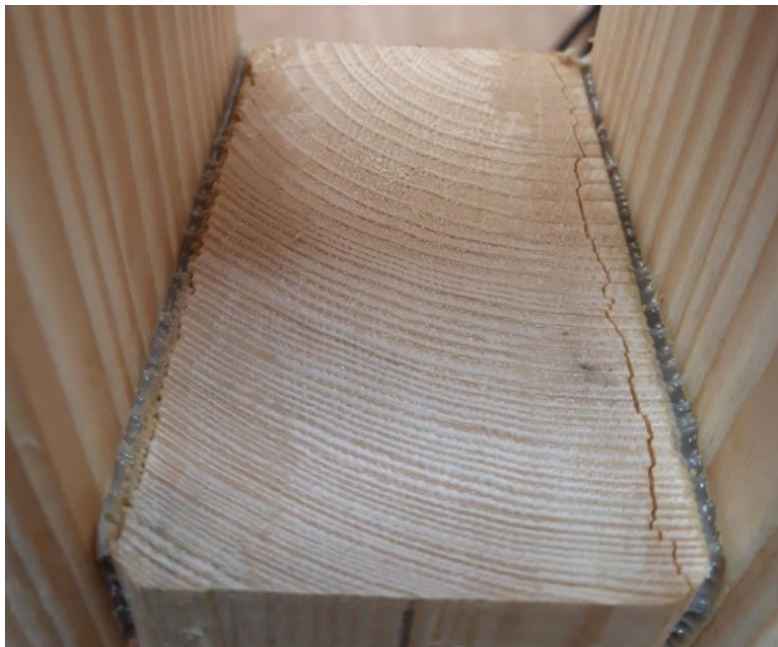
Фиг. 12. Разрушение на образца, вследствие на срязване на дървесината
