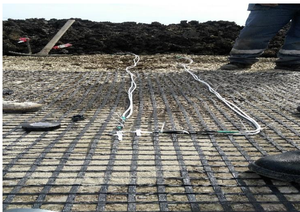
Фиг. 3. Положени датчици по ребрата на геомрежата
