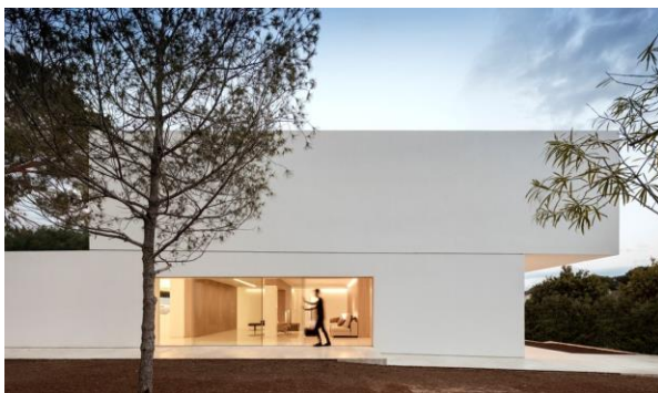
Фиг. 18. Къща сред борове (2015 г.). Франк Силвестър Архитектос
