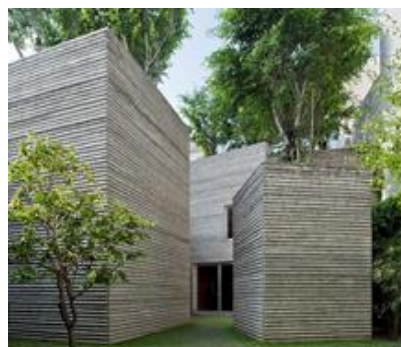
Фиг. 12. Къща с дървета (2014 г.). ВТН Архитекте
