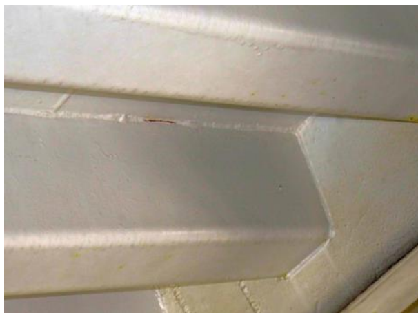
Фиг. 10. Уморна пукнатина в стоманена ОПП на стоманен виадукт
