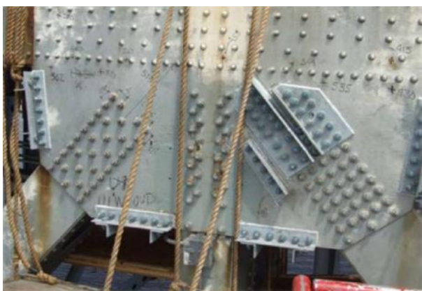
Фиг. 7. Усилена възлова плоча на стоманен мост [31]
