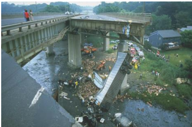
Фиг. 17. Разрушение на окачен отвор на мост в САЩ, 1983 г. [36]
