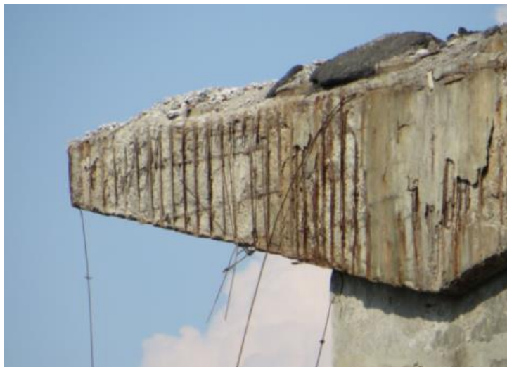
Фиг. 1. Стълб на стоманобетонен мост по АМ Тракия при извършване на аварийен ремонт, 2015
