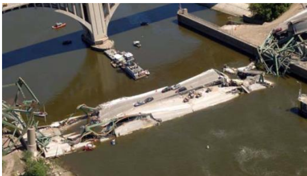
Фиг. 5. Аварирал стоманен мост в Минеаполис, 2007 г. [25]
