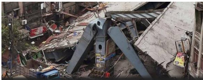
Фиг. 8. Комбиниран стомано-стоманобетонен мост в Калкута, Индия [17]
