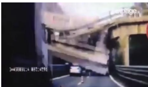
Фиг. 16. Разрушение на стоманобетонен герберов зъб на мост в Италия, 2016 г. [38]
