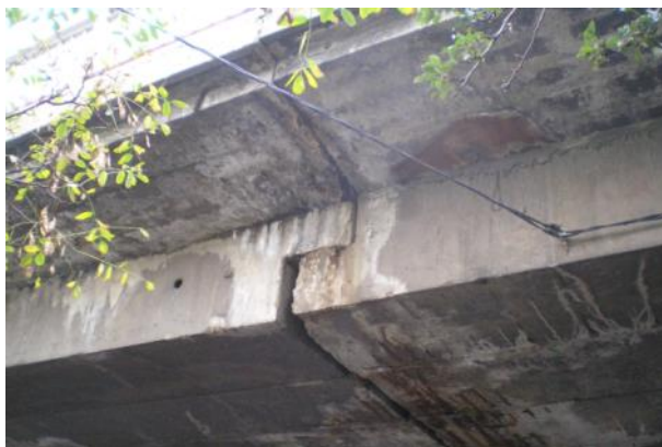
Фиг. 15. Стоманобетонен герберов зъб на мост в гр. София, 2008
