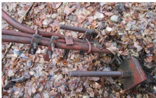
Фиг. 12. Зона на закотвяне на главен кабел на мост над р. Искър до Пасарел
