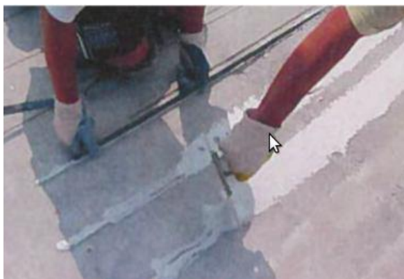
Фиг. 2. Усиливаща пластина в шлиц [9]
