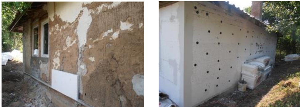
Фиг. 6. Етапи от реконструкцията – полагане на EPS панели
