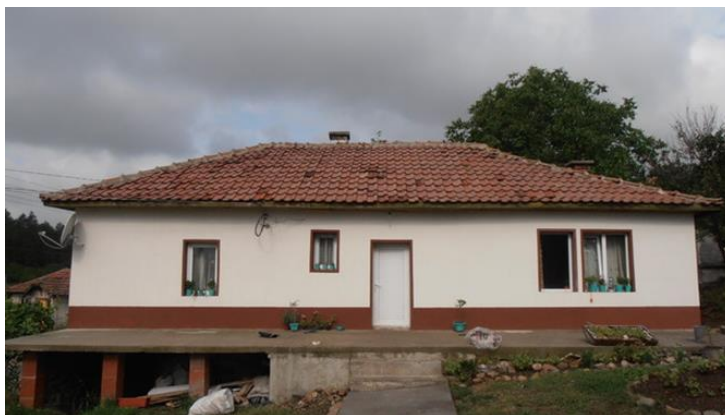
Фиг. 7. Завършен вид на главната фасада след реконструкцията
