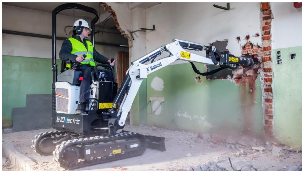
Фиг. 3. Машинно разрушение на преградна стена с хидравличен чук [5]
