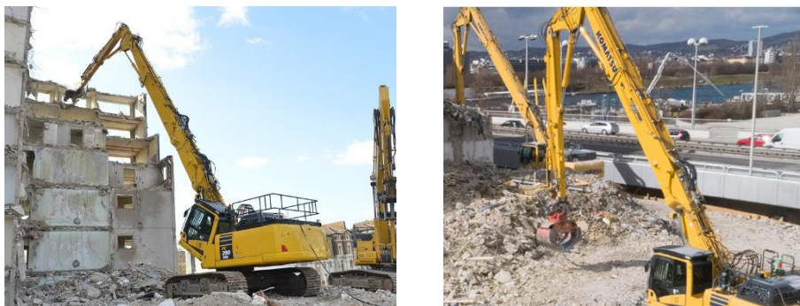
Фиг. 6. Машинно разрушение с хидравличен багер [8]
