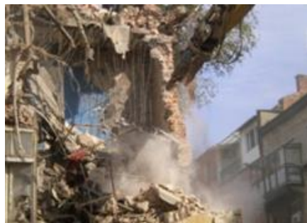
Фиг. 4. Неселективно разрушаване на жилищна сграда – гр. София, ул. „Славянска“, 2012 г.
