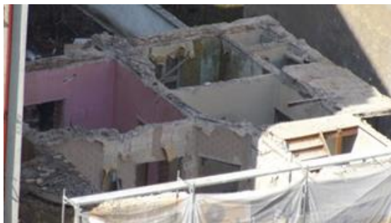
Фиг. 5. Селективно разрушаване на жилищна сграда – гр. София, бул. „Христо Смирненски“, 2017 г.
