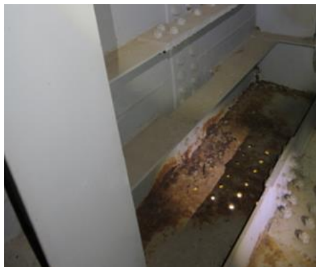
Фиг. 4. Корозия във вътрешността на кутията около отвори
