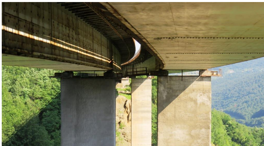
Фиг. 1. Стоманен виадукт с ОПП по АМ Хемус 100+162+100 m
