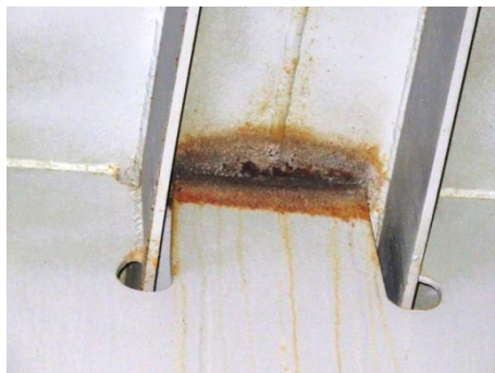
Фиг. 3. Премахване на надлъжните ребра през стъблото на напречната греда
