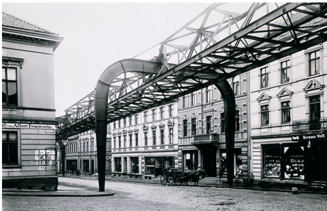
Фиг. 1. Портална рамка, служеща за опора на окачения релсов транспорт в град Вупертал, Германия [16]
