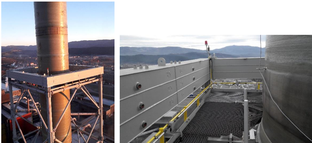
Фиг. 4. Монтиран демпфер при горната площадка на опорната конструкция
