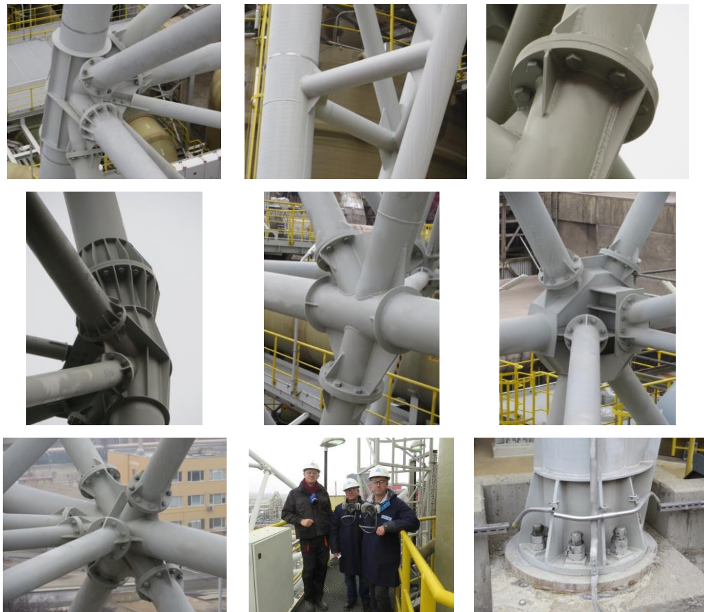
Фиг. 6. Детайли на възли от стоманената конструкция
