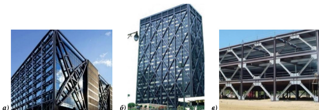
Фиг. 1. Приложения на вертикалните връзки в съвременното строителство а) Cannon Place Building, London; б) Alcoa Building, San Francisco, California; в) Split-X
