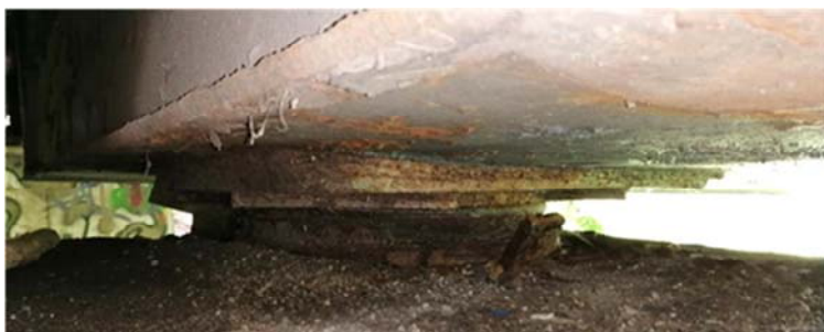
Фиг. 8. Интензивна корозия на главна греда при устой Младост
