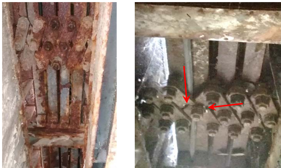
Фиг. 11. Състояние на дилатационната фуга при устой Младост: интензивна корозия, счупени части на лостово-ножичния механизъм и преминаваща светлина
