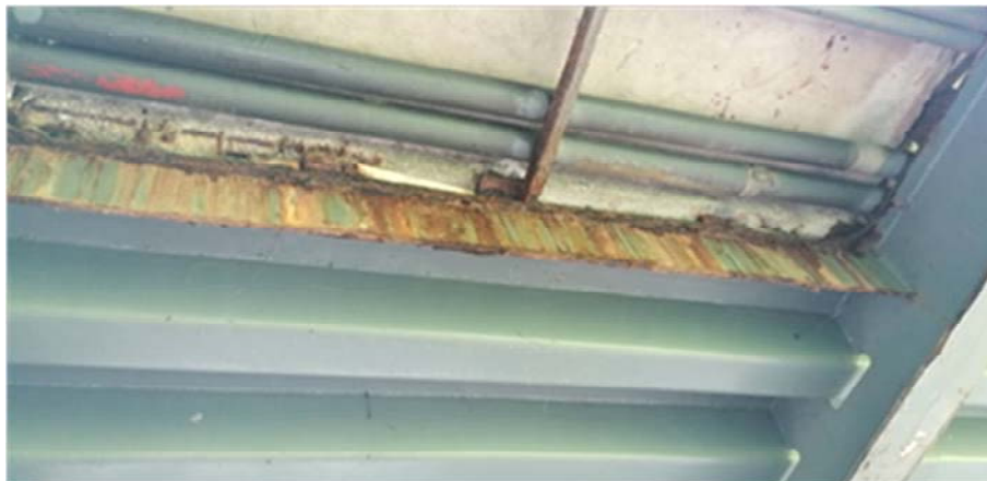
Фиг. 7. Конзолна част и интензивна корозия на крайното плоско надлъжно ребро
