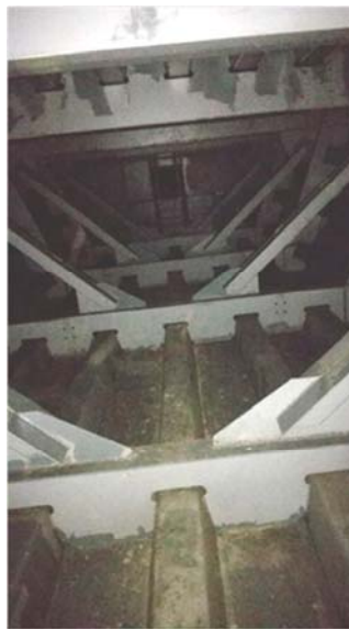
Фиг. 3. Изглед от вътрешността на моста – корави прътови диафрагми
