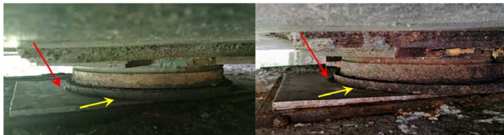
Фиг. 10. Функциониране на подвижните лагери
