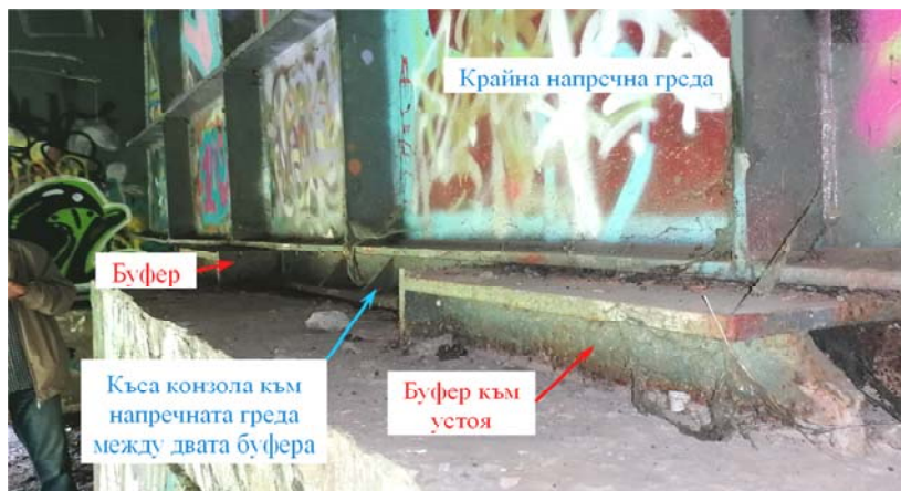
Фиг. 4. Устройство за предаване на хоризонталните напречни опорни реакции
