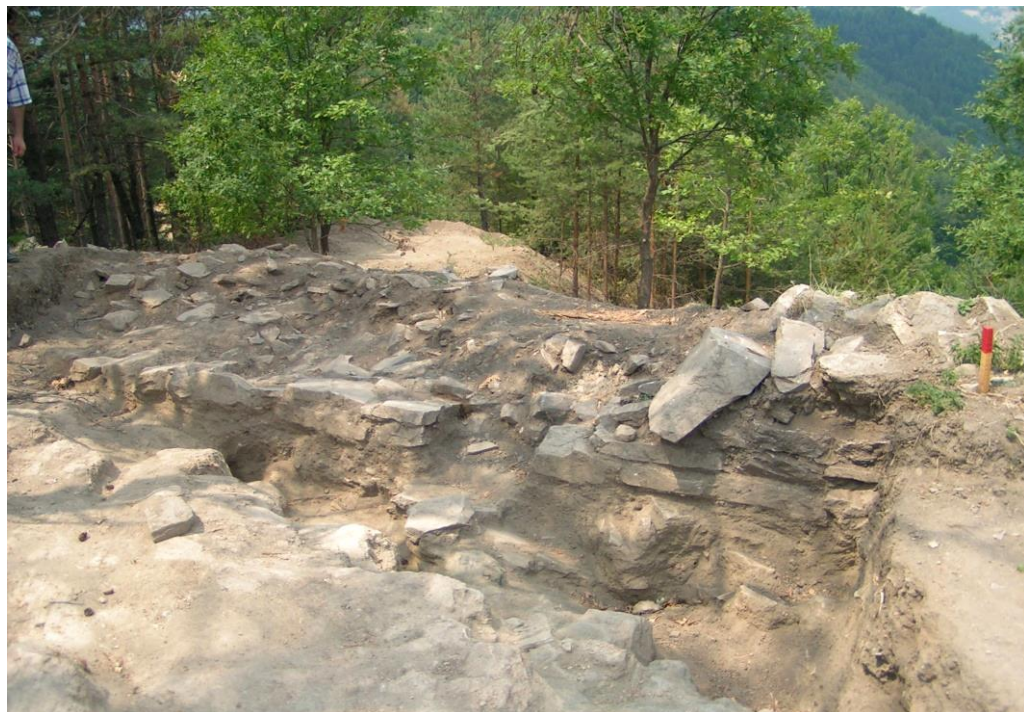
Фиг. 1. Архитектурната субстанция от светилището в м. Караборун (едно от трите светилища, предмет на проекта) по време на археологическото проучване. Местоположението на обекта е високо в планината, в труднодостъпна територия. Снимка: личен архив на арх. Й. Кандулкова
