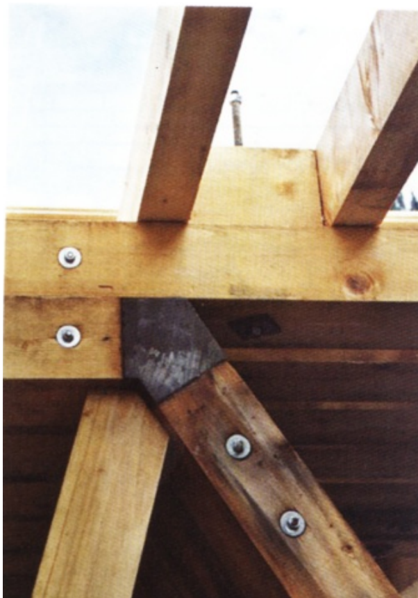
Фиг.6.11. Възел на подкосно-ригелна система
