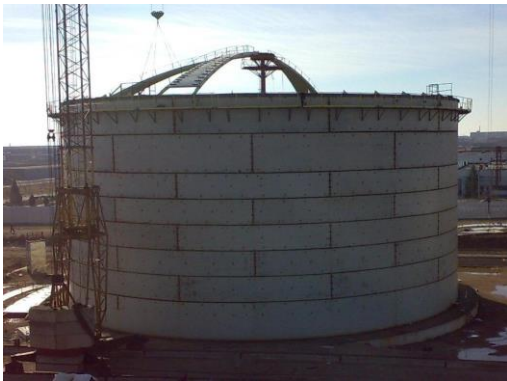
а) с използване на временна стойка
