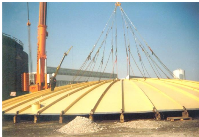
в) чрез сглобяване на земята и повдигане като едно цяло
