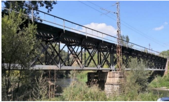
Фиг. 1. Общ вид на изследвания стоманен мост на km 18 +985
