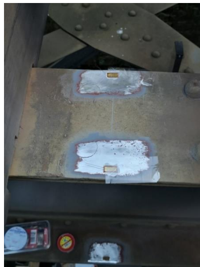
б) залепване на електросъпротивителни датчици
