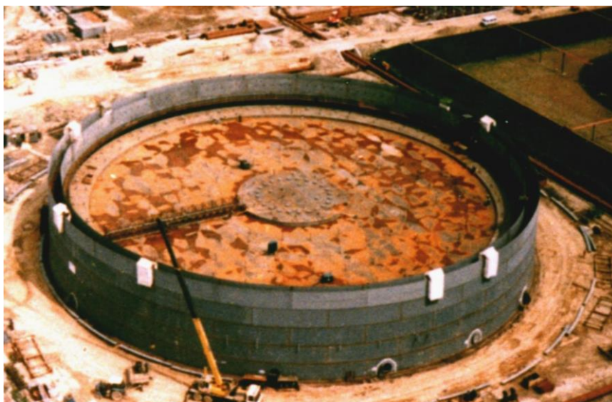
фиг. 7 Монтаж на резервоар с централен понтон, Германия
