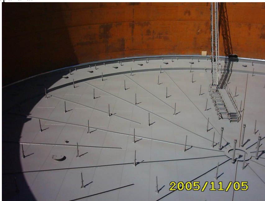
фиг. 6 Укрепване на мембраната с радиални ребра, Судан
