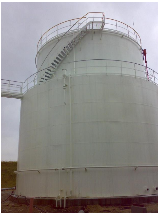
фиг. 2 Стоманен резервоар с двойни корпус и дъно
