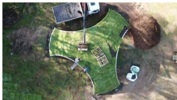
Изпълнение на покривно тревно покритие „Recycleshell“, Университет Кайзерслаутерн,
