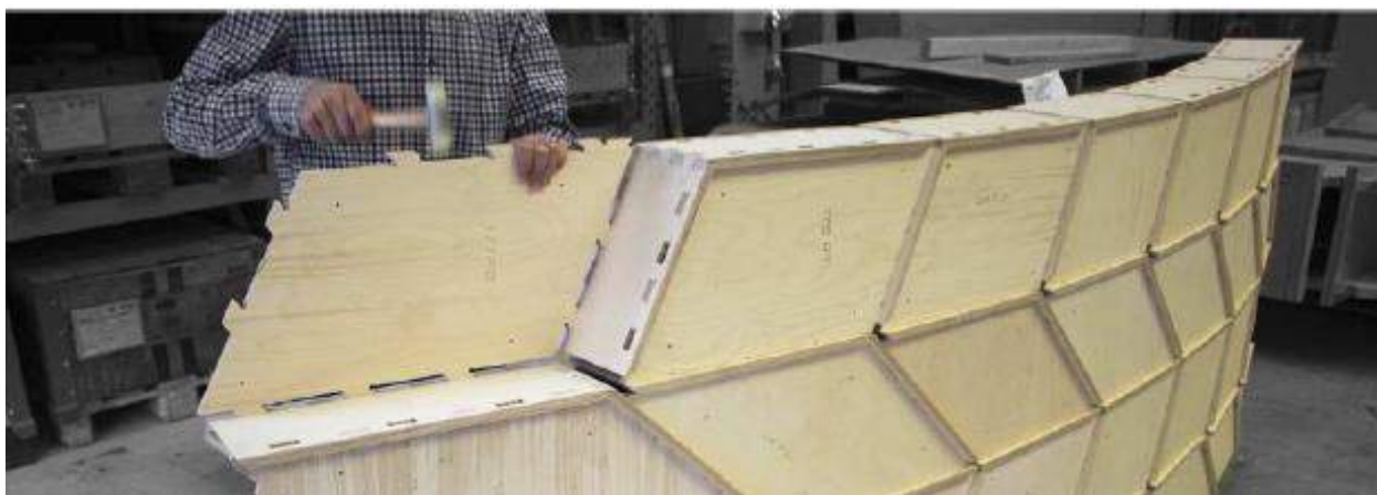
Фигура 3. 4 Съвременно решение за сглобка на зав. произведени елементи от LVL 26
